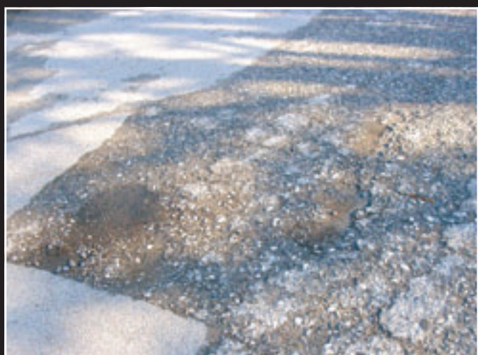
Asfaltirana cesta na Ulici stare pravde se spreminja v makadam kljub temu, da občina za vzdrževanje cest daje več milijonov EUR letno.
