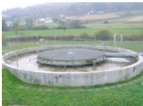
Bazen sekundarnega čiščenja ČN Mirna Peč (1000 PE)
