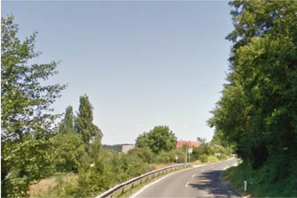
Slika 11: Pogled iz smeri Soteske na slabo pregleden cestni priključek v km 9+564 desno
