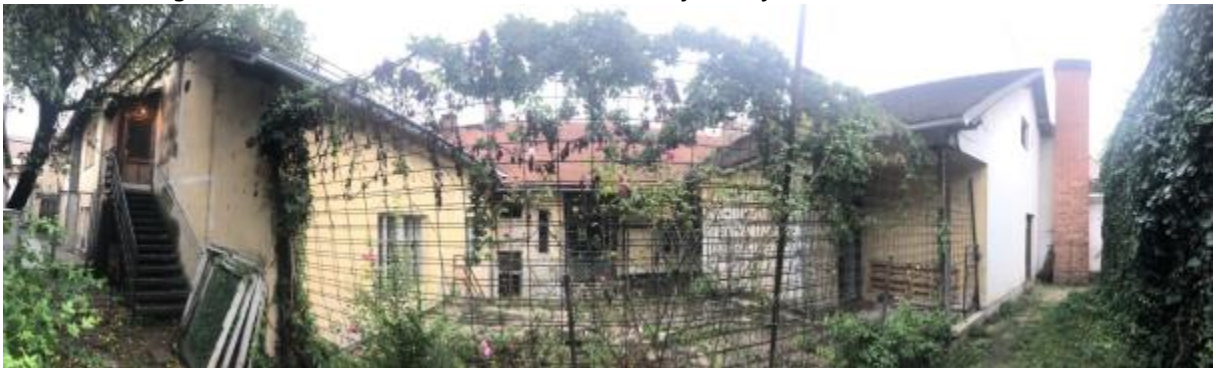
Slika 17: Pogled z zahodne strani na oba stika s sosednjimi objekti in dvoriščni del
