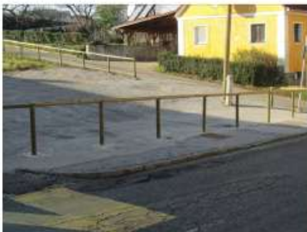
Zavarovano začasno parkirišče
