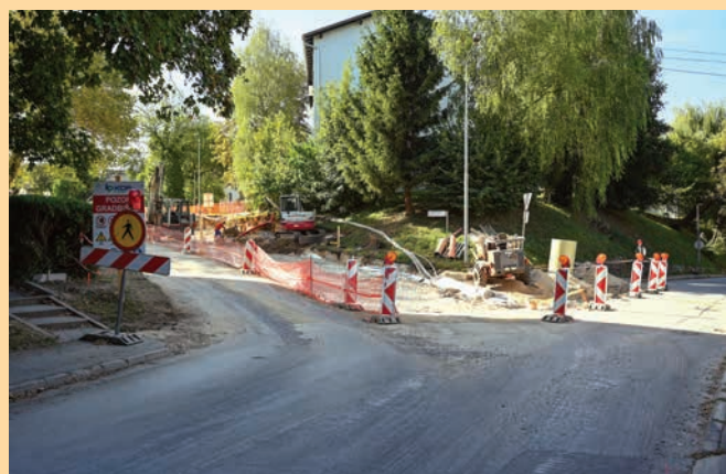
S prenovo Jakčeve in Ragovske ulice v Novem mestu nadaljujemo s sistematičnim urejanjem cestne infrastrukture in komunalnih omrežij z namenom zagotavljanja večje prometne varnosti za vse.
