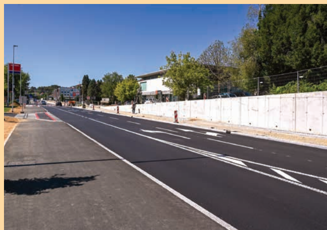
Konec avgusta je bil sproščen promet na Seidlovi cesti. Zaključna dela so v teku, ena ključnih mestnih vpadnic pa s celovito prenovo prinaša pomembno izboljšanje prometnih razmer in večjo varnost za vse.
