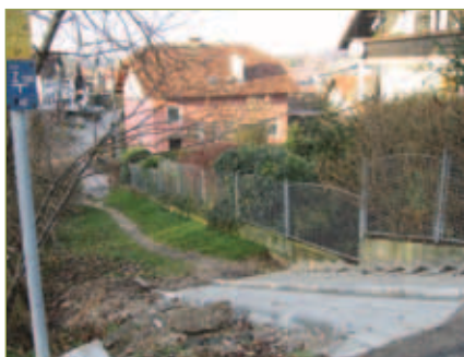
Začetek urejanja prehoda za pešce in kolesarje med Paderšičevo in Skalickijevo ulico.
