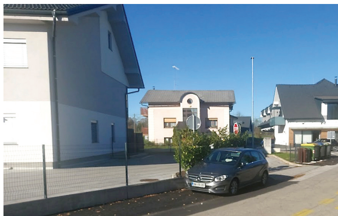
Ureditev poškodovanega cestišča na začetku Šukljatove ulice
