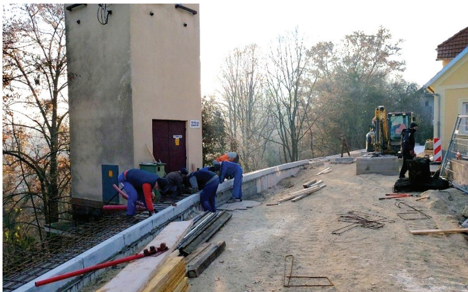
Tako se je novembra 2020 pričelo s širitvijo ceste, ureditvijo pločnika in sanacijo usada.
