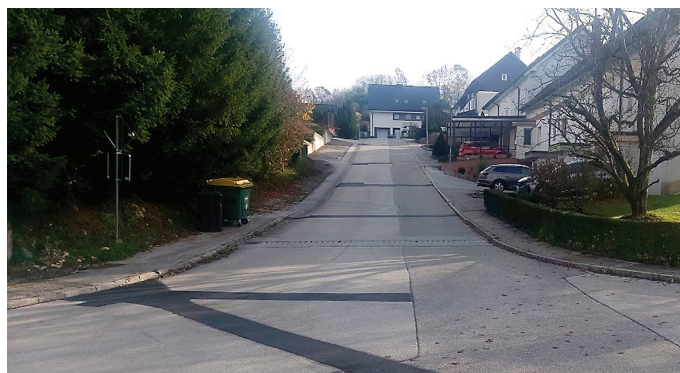
Ureditve na več mestih poškodovanega cestišča na Košenicah
