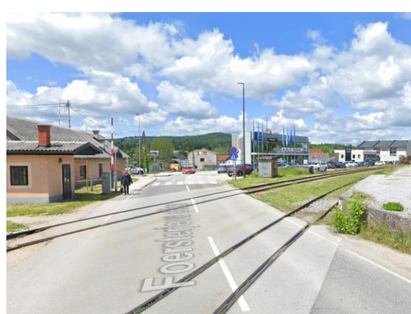
Prehod ceste Bršljin prek železnice LJ - NM - Metlika, ki bo predmet rekonstrukcije s podvozom.
