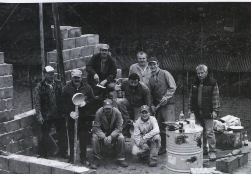
Gradnja objekta v Dragah.
