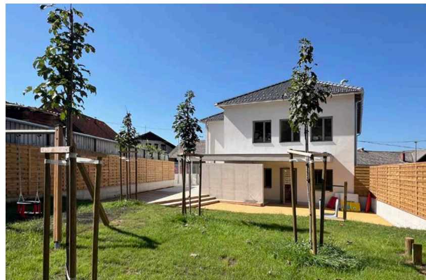
Foto 41: „Odkopana“ dvoriščna fasada z večnamensko ploščadi in lesenim odrom. Vir: Mojca Gregorski, 2025.
