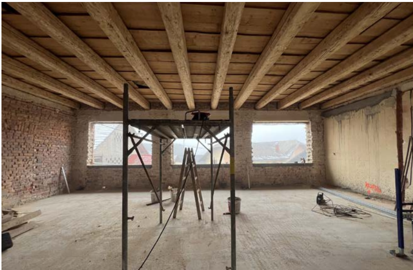
Foto 36: Izvedba nove betonske plošče nad pritličjem in ohranitev lesene konstrukcije stropa v 1.nadstropju. Vir: Mojca Gregorski, 2024.
