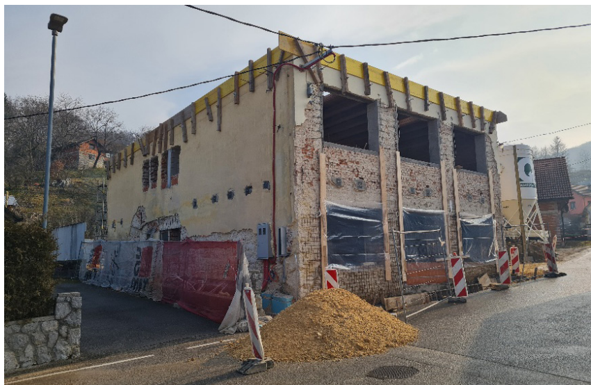
Foto 30: Statična utrditev objekta. Vir: KS Gabrje, 2024.
