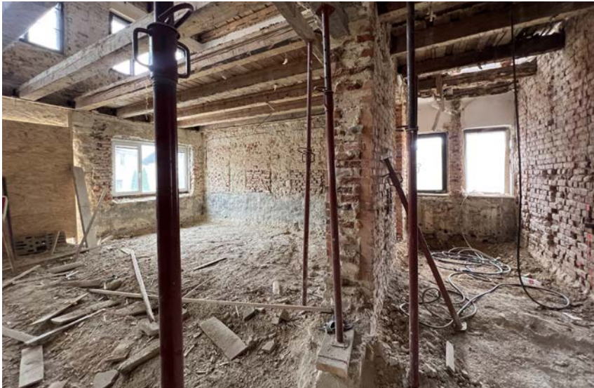
Foto 35: Odstranitev nenosilnih zidov in vseh ometov. Levo zadaj zazidana okna nekdanje gostilne. Vir: Mojca Gregorski, 2024.
