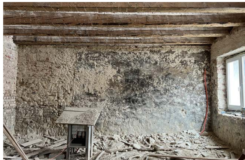
Foto 32: Kamnita stena pritličja z vidnimi sledovi požiga. Vir: Mojca Gregorski, 2024.
