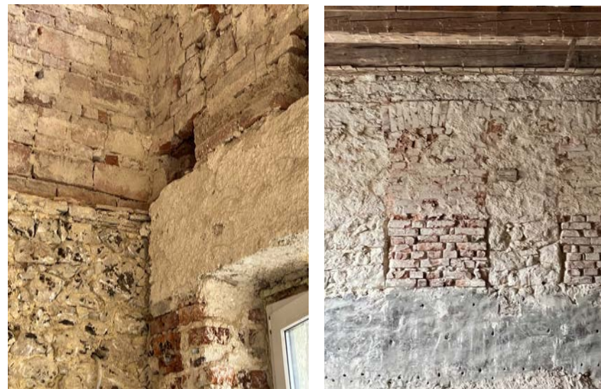
Foto 33 (levo): Različne časovne plasti gradnje: kamen, opeka, beton. Vir: M. Gregorski, 2024. Foto 34 (desno): Zazidana okna nekdanje gostilne. Vir: Mojca Gregorski, 2024.
